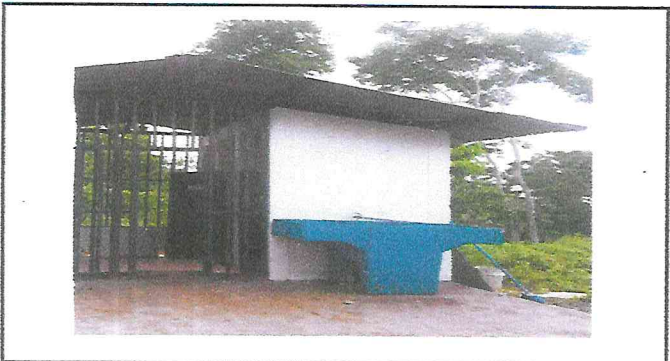
Foto 3: Sustitución de pila con su base de concreto
