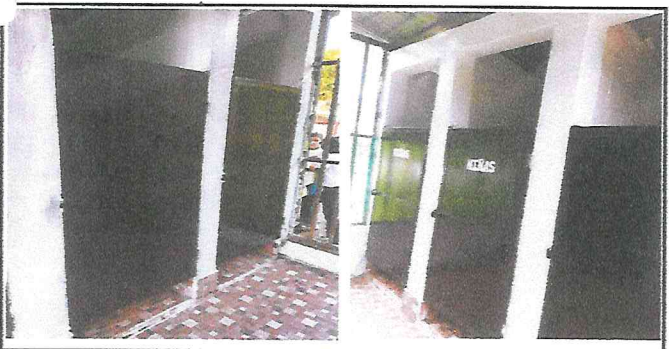
Foto 5: sustitucion de puertas de los baños
