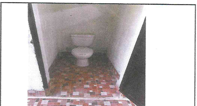
Foto 4: Sustitucion de inodoros
